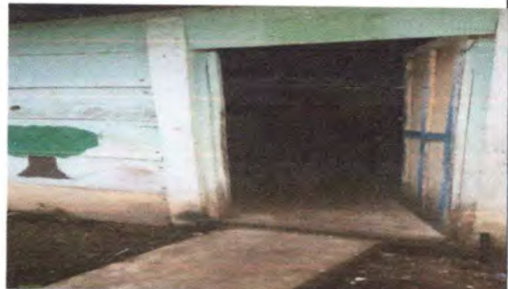
Foto 4: Sustitución de piso de concreto.
