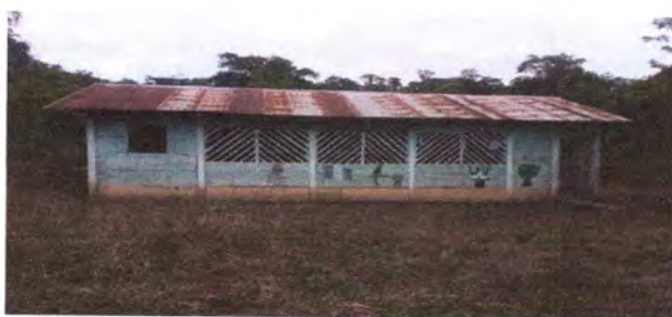
Foto 5: sustitucion de ventanas de madra por ventans de metal.
